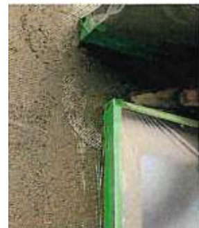
扉と窓の間にも簡単に作業できる
