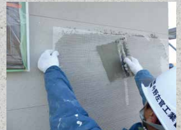
ベースコート、メッシュ施工
